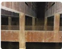
Kühlwasser ist immer mehr oder weniger stark korrosiv. **Korrosion** zerstört langsam die Metallteile im Kühlsystem und führt langfristig zu deren Ausfall.
