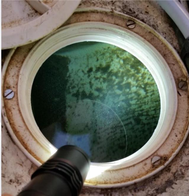
In Wassersystemen von Schiffen, Zügen, Wohnmobilen etc. bilden sich nach kurzer Zeit Biofilme an der Oberfläche.
