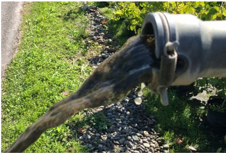
Purgado de capas de biopelícula disueltas tras una desinfección de choque (1 ml Super 25/l de agua) procedente de una tubería de agua.
