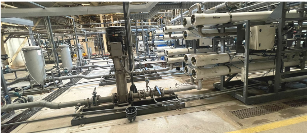
Instalaciones industriales de tratamiento de agua con prefiltros (izquierda) y filtros de membranas (derecha)
