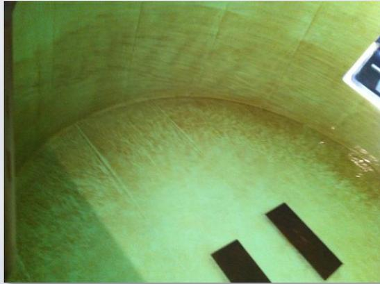
Cámara de agua potable con depósitos
