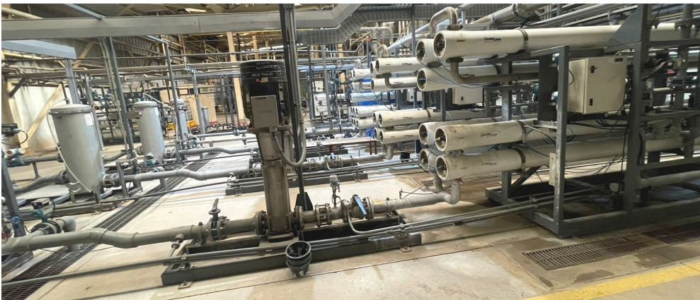
Installation de traitement de l'eau industrielle comprenant des préfiltres (à gauche) et des filtres membranaires (à droite)
